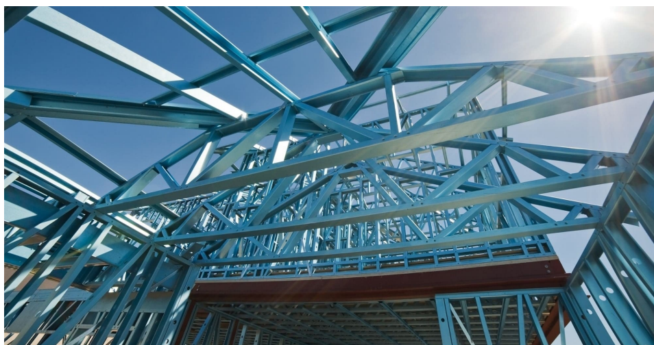
Изцяло метална конструкция на къщата
