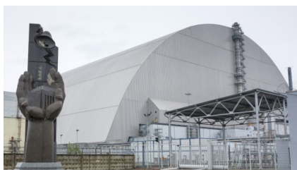
Саркофаг над Чорнобильською АЕС.
