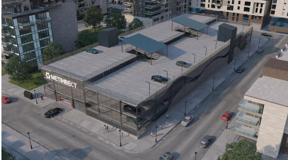
Несущие конструкции паркинга – стальные балки и колонны – сварные и выполнены из листа, что снижает металлоемкость здания и сокращает затраты на строительство. В проекте используются железобетонные перекрытия по несъемной опалубке с применением профлиста.
