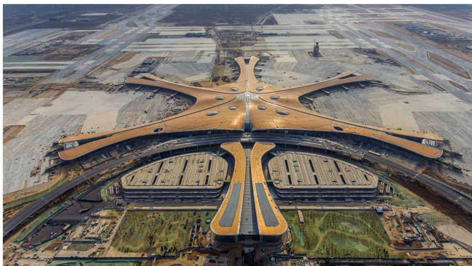
При строительстве аэропорта использовались сложные технологические решения. Тысячи демпфирующих элементов встроены в стальное основание здания. Они создают прослойку для амортизации и компенсации вибрации от идущих на взлет самолетов и несущихся с огромной скоростью поездов.
