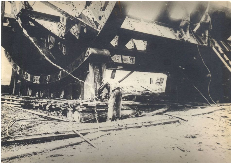
Сборка качающейся мартеновской печи 1935г.
