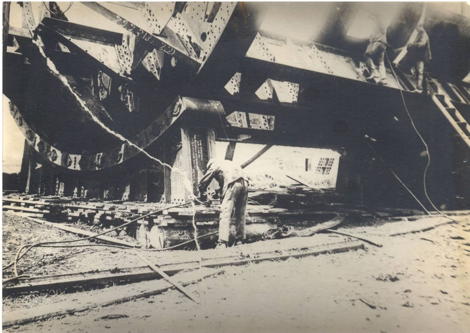
Сборка качающейся мартеновской печи 1935г.
