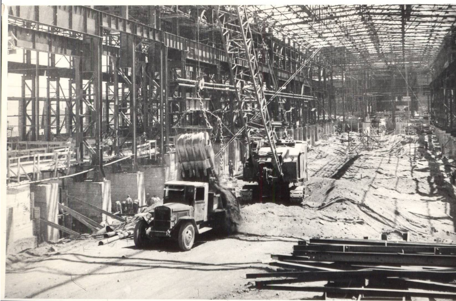
Закладка сталелитейного цеха
