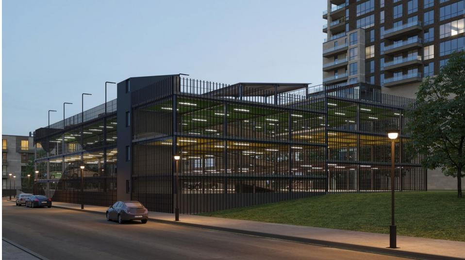
Нужно только подобрать фундамент, который соответствует геологии участка, разработать генплан и выполнить оценку объекта на окружающую среду. Все остальные этапы проектирования и разработки необходимой документации уже входят в состав проекта. Строительство 4-этажного паркинга с крышей на 217 машин занимает примерно полгода, монтаж каждого нового модуля – еще полмесяца.
